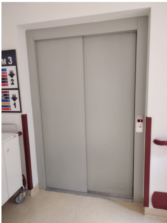
Zdjęcie 6: Widok drzwi szybowych z aktualną obróbką wokół drzwi
