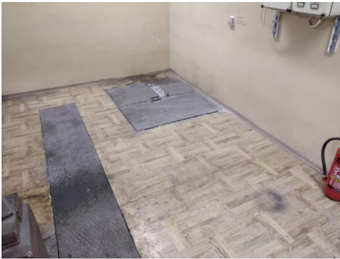
Zdjęcie 3: Widok wjazdu luku montażowego w maszynowni
