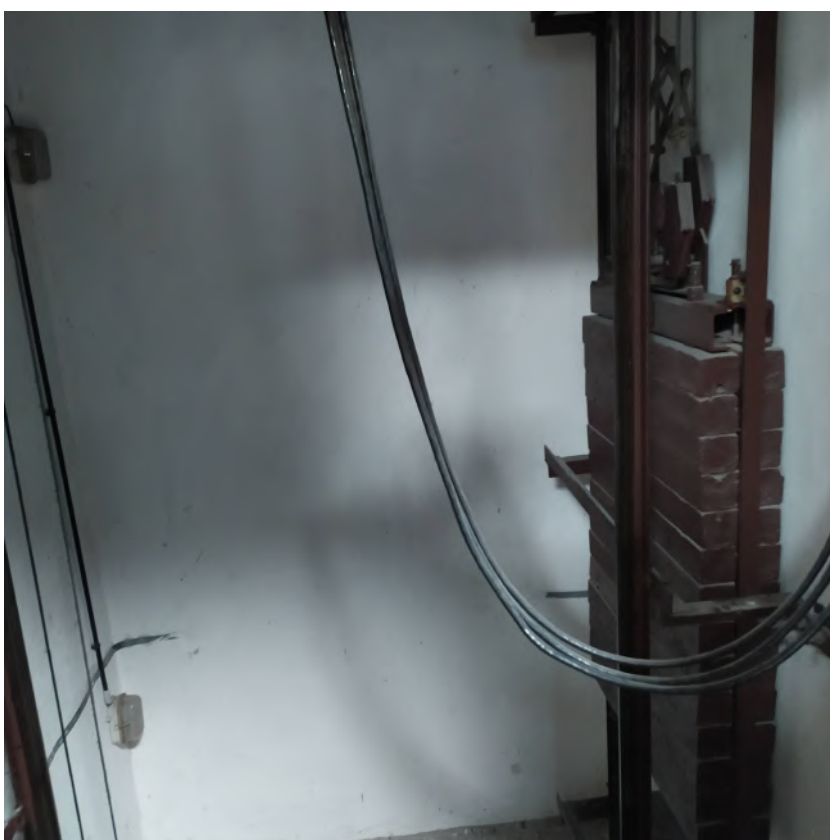
Zdjęcie 5,6: Widok wnętrza szybu
